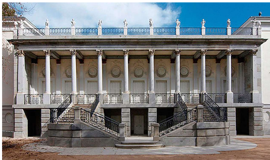
Fig. 1. Palacio de la Alameda de Osuna
